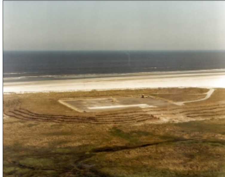
De gaswinningslocatie op Ameland-Oost in 1983 direct na de aanleg.
