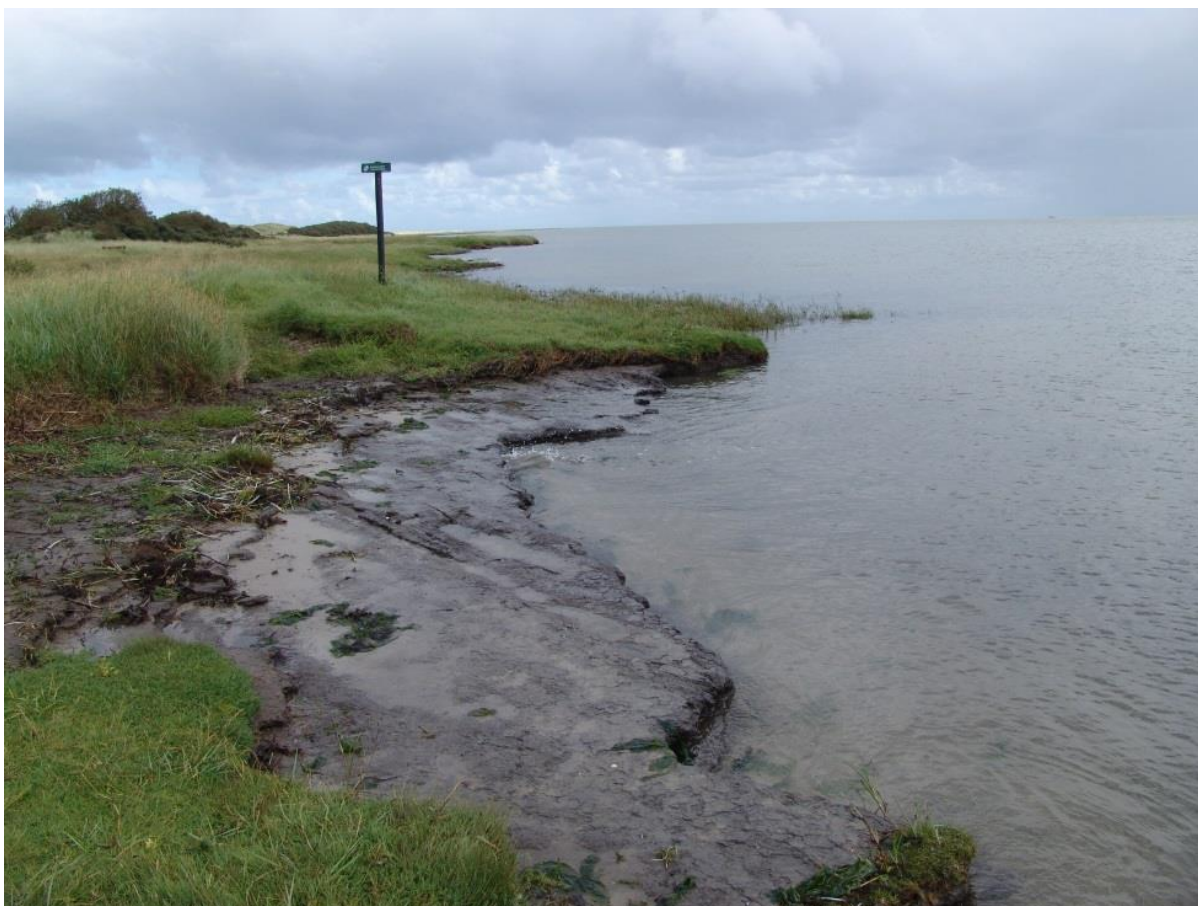
Figuur 2.60. Kwelderrand met kustafslag onder het Oerd (augustus 2004; foto © Ruut Wegman).
