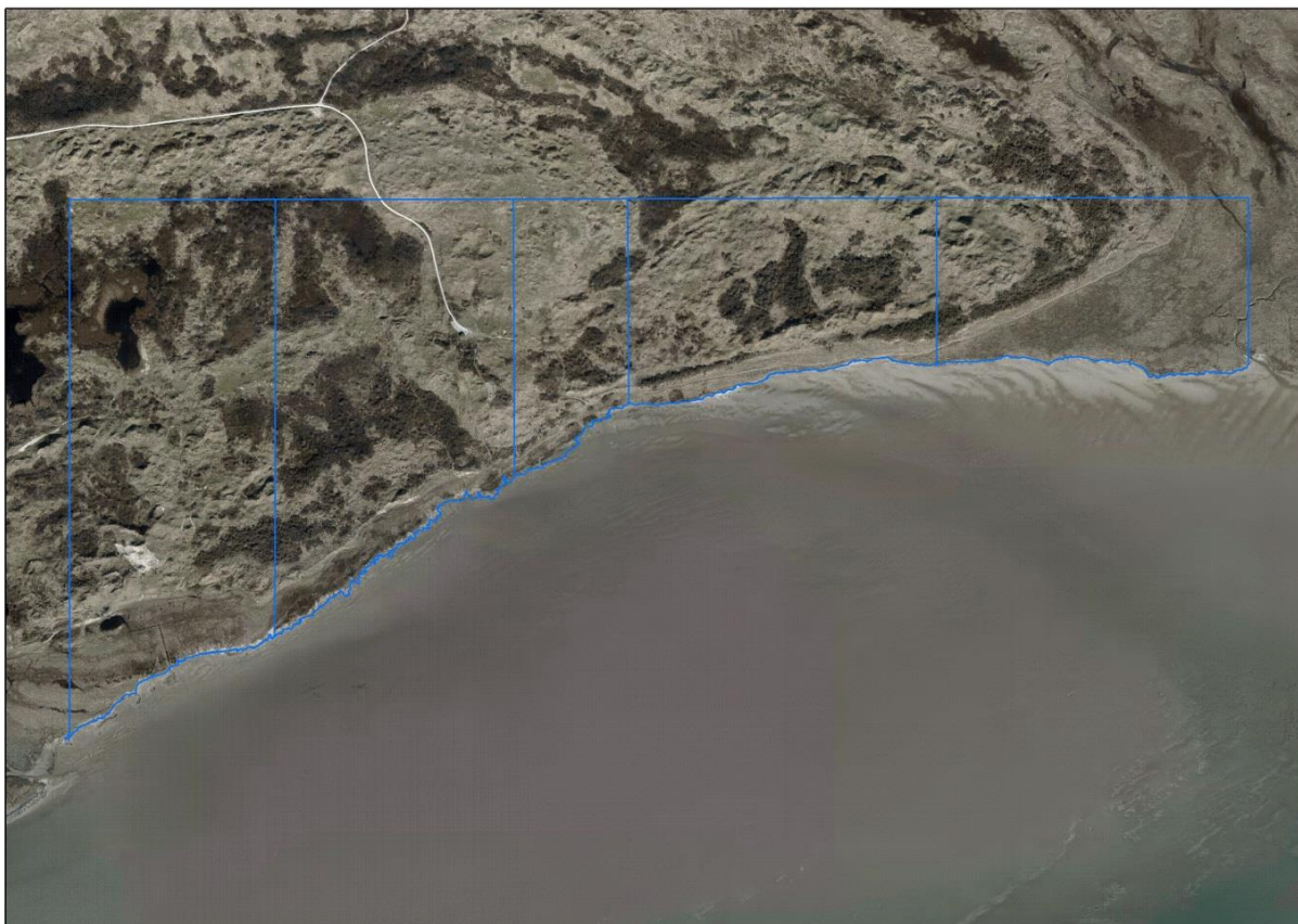
Figuur 2.61 Luchtfoto van de kwelderrand onder Oerderduinen in 2014 met van west naar oost de deelgebieden 1 t/m 5.
