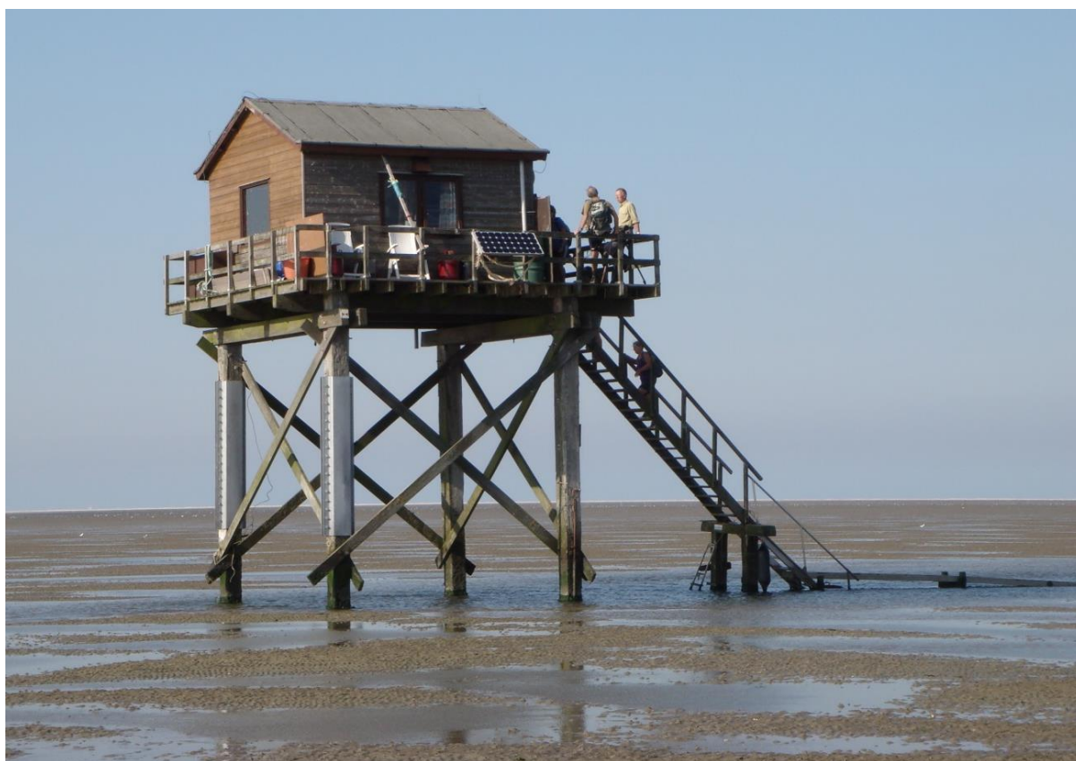
Figuur 2.52 Het reddingshuisje op de Engelsmanplaat. Het onderste deel van de trap, met de dunne leuning, is er extra aan gemaakt vanwege de erosie van de plaat.
