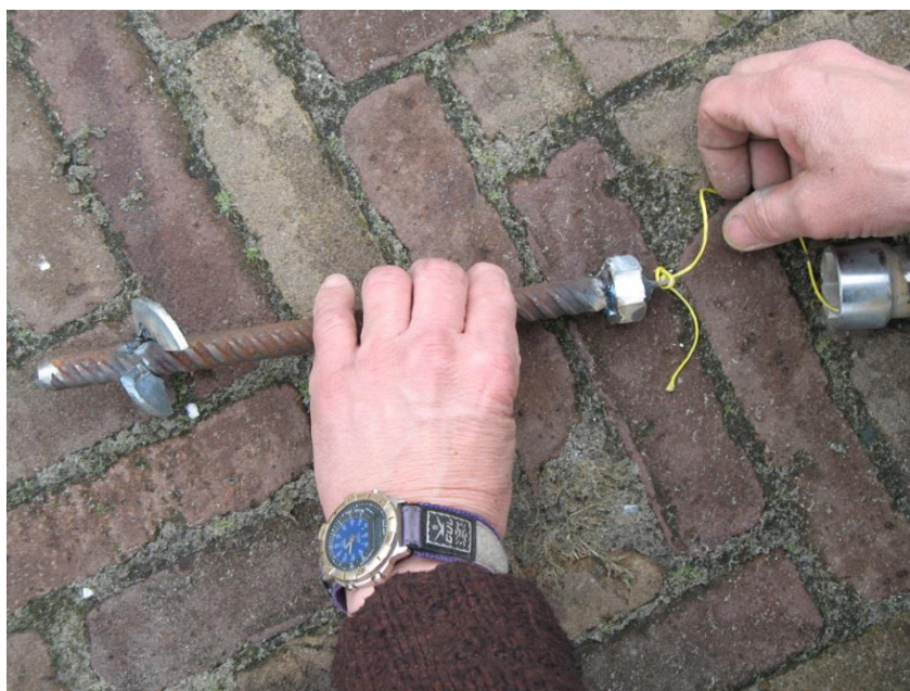
Figuur 2.27 Eigenbouw grondanker waaraan niet rekkend meettouw bevestigd wordt. Rechts de dop aan het uiteinde van de T-grondboor waarmee het anker in de bodem geschroefd wordt (figuur 2.28).
