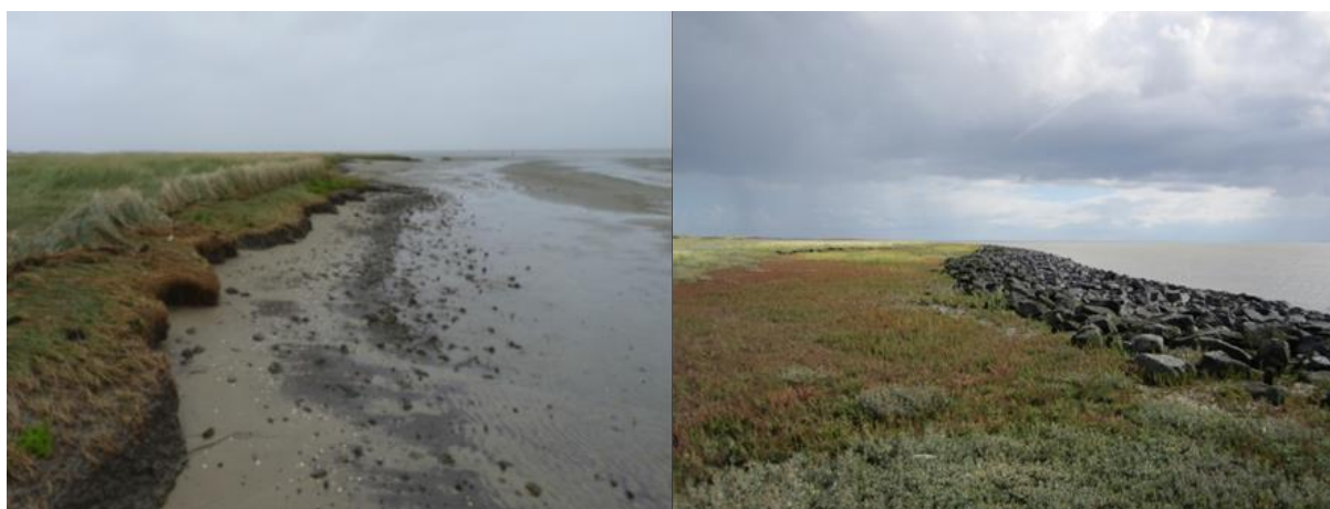
Figuur 4.10 Stortstenen oeververdediging op Neerlands Reid (links) en kliferosie kwelderrand De Hon (rechts) (foto's: Alma de Groot).
